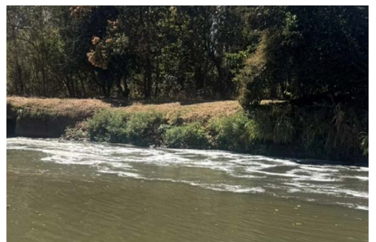
Espuma formada em Estação de Tratamento foi identificada como fonte do fenômeno no Rio Meia Ponte
