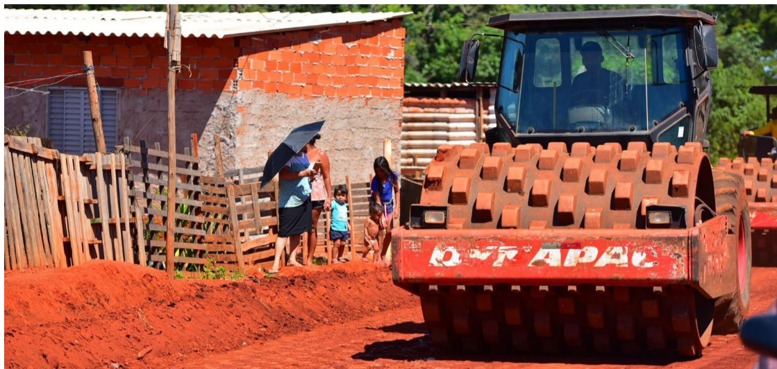
Gestores realizam vistorias em obras da Capital: intervenções têm prazo para conclusão até o final de 2024
