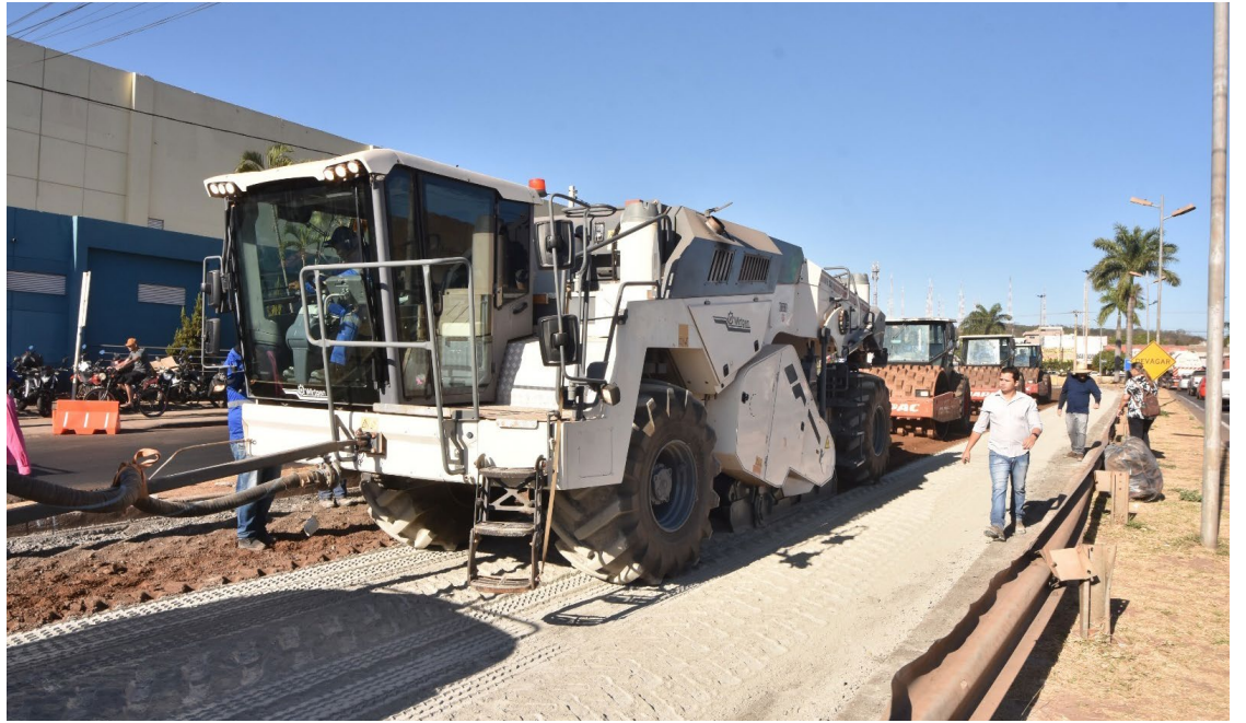
Recicladora é utilizada na obra de reconstrução da avenida Perimetral
