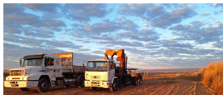
As obras devem ser concluídas em seis meses a partir do método "moldado in loco"
