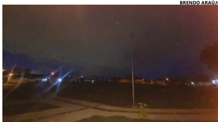
Escuridão na Estação de Esporte do Bairro Calixtolândia. Troca de lâmpadas não tem sido efetuada
