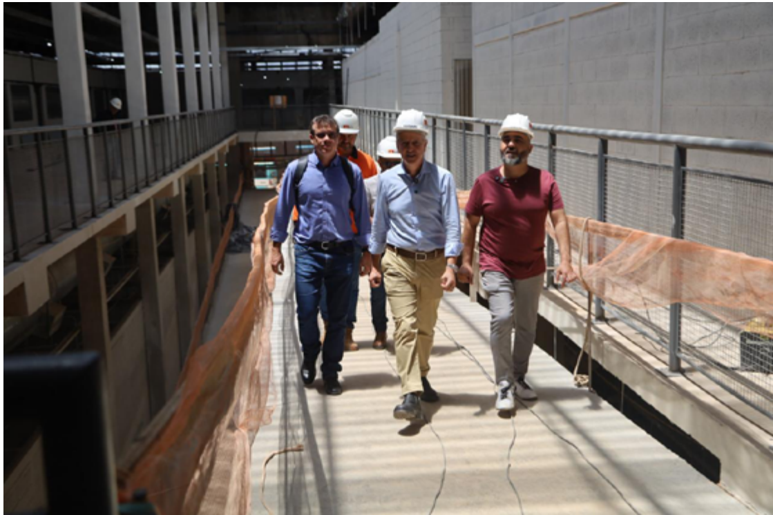
Joel Sant'Anna vistoria obras dos Mercadões de Águas Lindas e Santo Antônio do Descoberto
