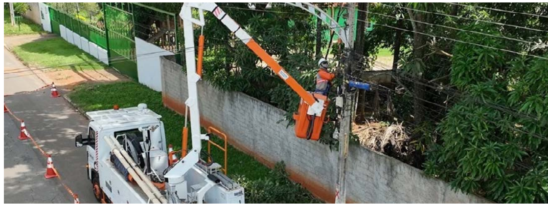
Com foco na prevenção de acidentes e interrupções, concessionária orienta população sobre podas e cuidados próximos à rede elétrica
