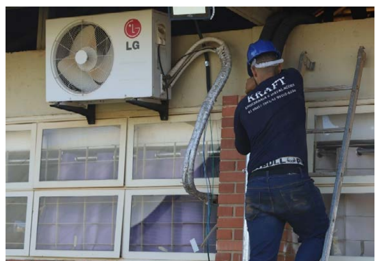
Trabalhos de adequação elétrica ocorrem na Escola Municipal da Paz, no Jardim Florença
