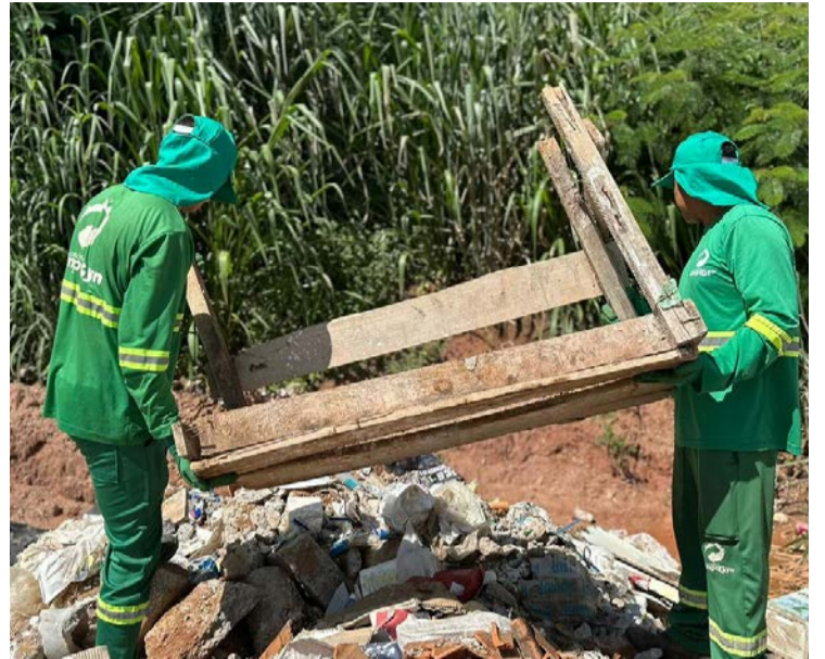
Objetivo é remover 6 mil toneladas de entulho
