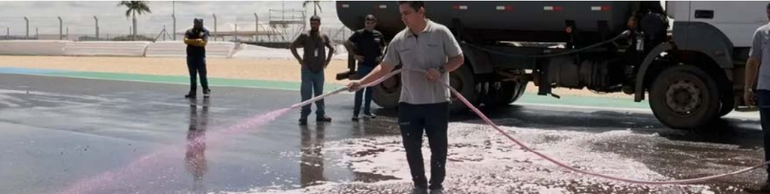
Serviço removeu impurezas como poeira, lama, fuligem e resíduos de óleo na pista
