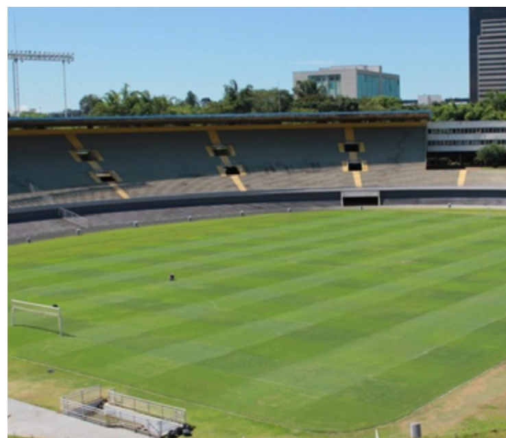
Complexo Serra Dourada pode se transformar em espaço multiuso: modernização depende de leilão
