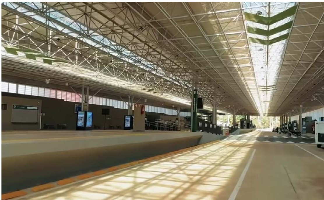
Terminal Praça da Bíblia que será hoje apresentado para população: reconstrução realizada no prazo previsto
