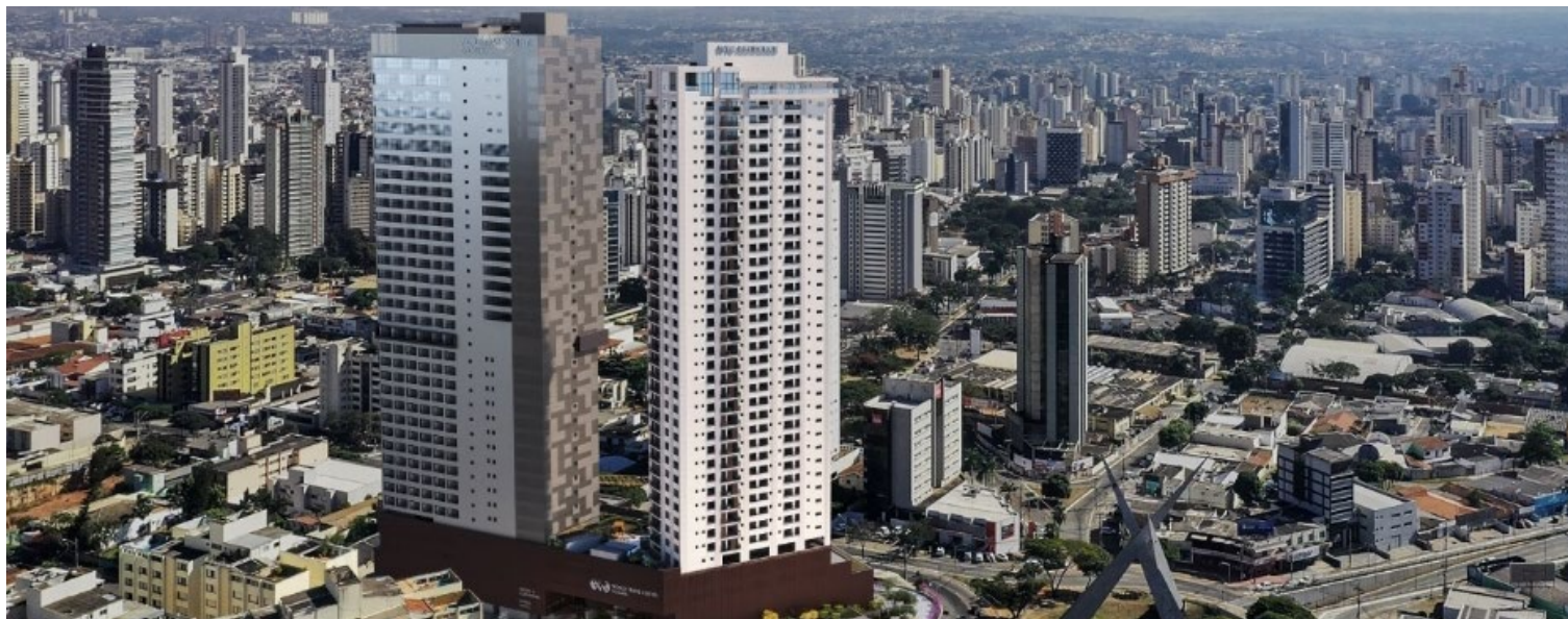
Localizado na praça do Ratinho, no setor Marista, empreendimento é avaliado em cerca de R$ 1 bilhão
