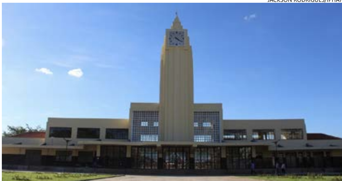
Goiânia abriga 22 edificações em estilo Art Déco tombadas pelo Iphan
