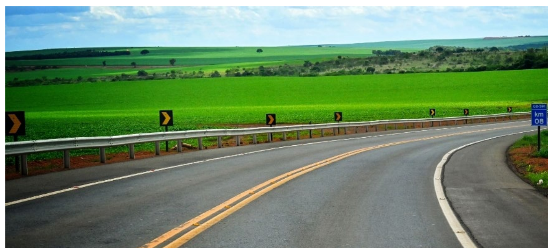
Obra facilita escoamento de itens como soja, milho, sorgo e leite
