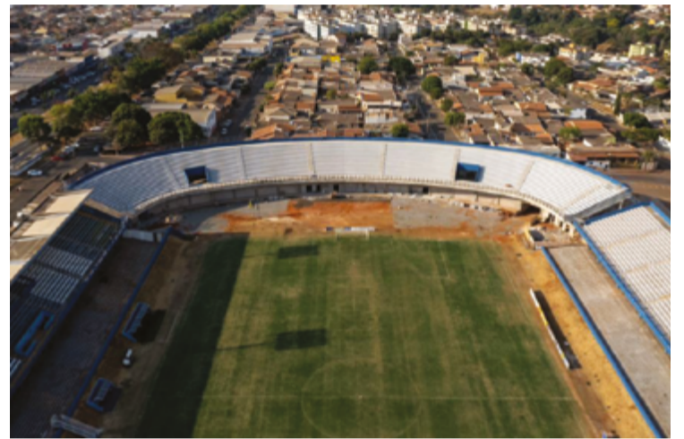
Além do fechamento do anel de arquibancadas, foram construídos novos vestiários, revitalizadas cabines de imprensa; gramado também passa por revitalização
