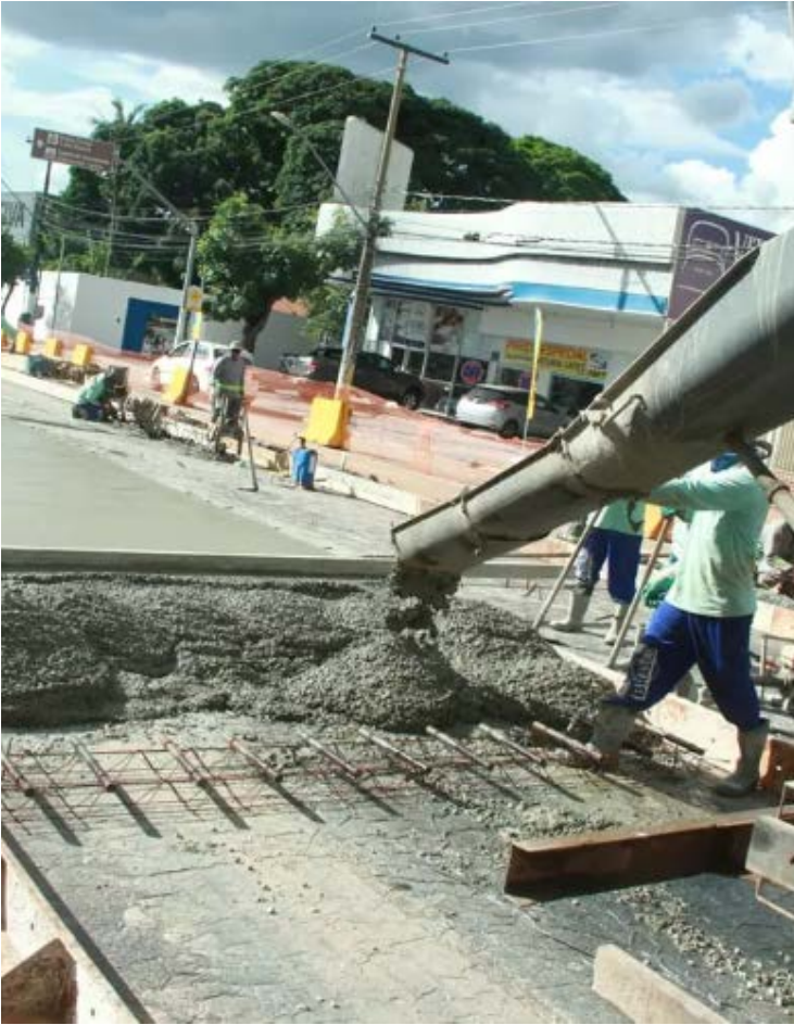
Estrutura foi planejada para melhorar o fluxo de veículos, reduzir conflitos no trânsito e ampliar a segurança para motoristas
