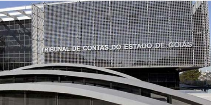
Sede do TCE em Goiás que disponibiliza dados sobre emendas no Observatório do Cidadão
