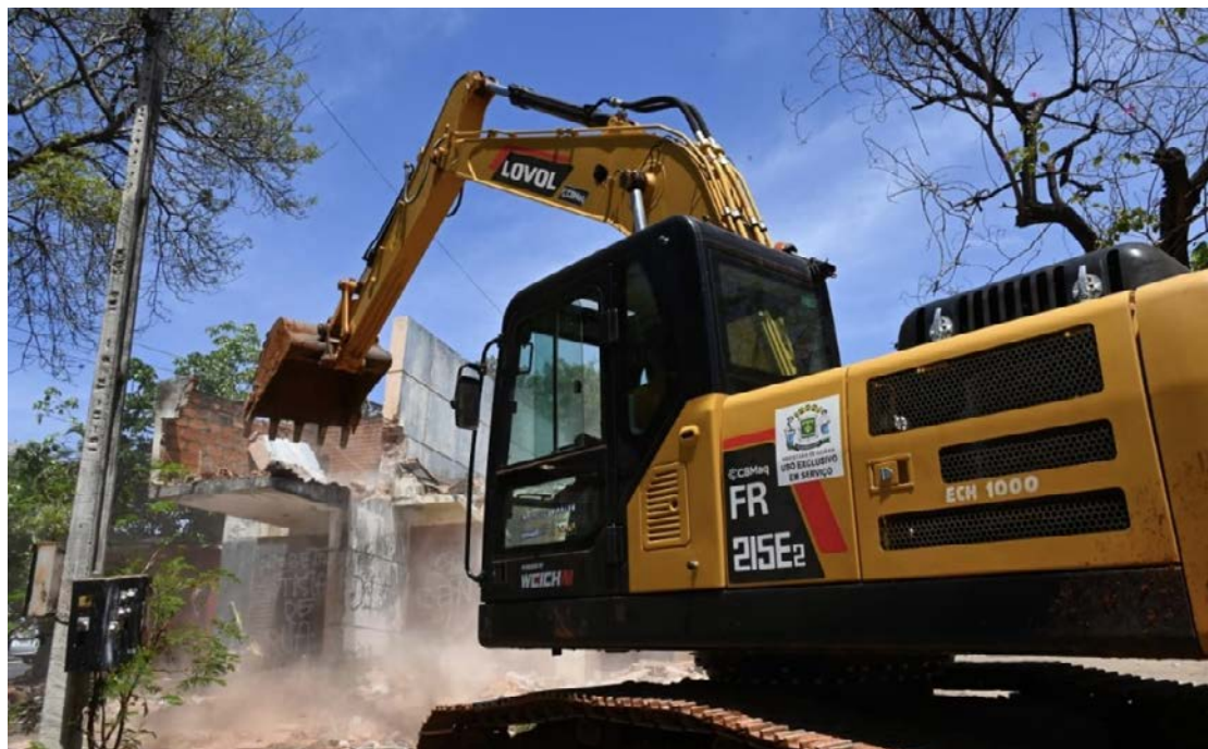
Primeiro prédio demolido foi um banheiro abandonado: gestão municipal pretende mapear construções
