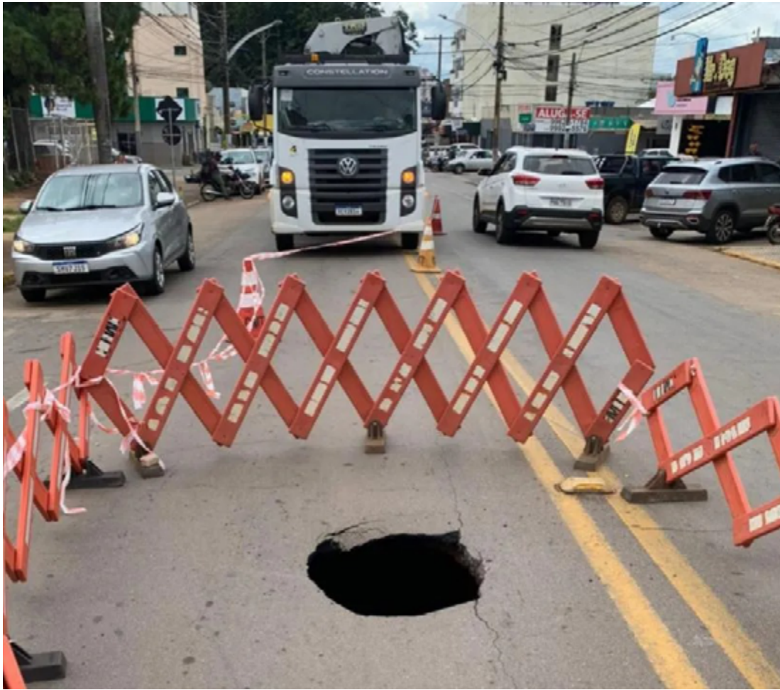
Cratera que se abriu na Avenida São Francisco, no Bairro Jundiá. Outra também surgiu na Radial Sul
