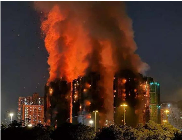
Incêndio atingiu várias torres de um complexo residencial
