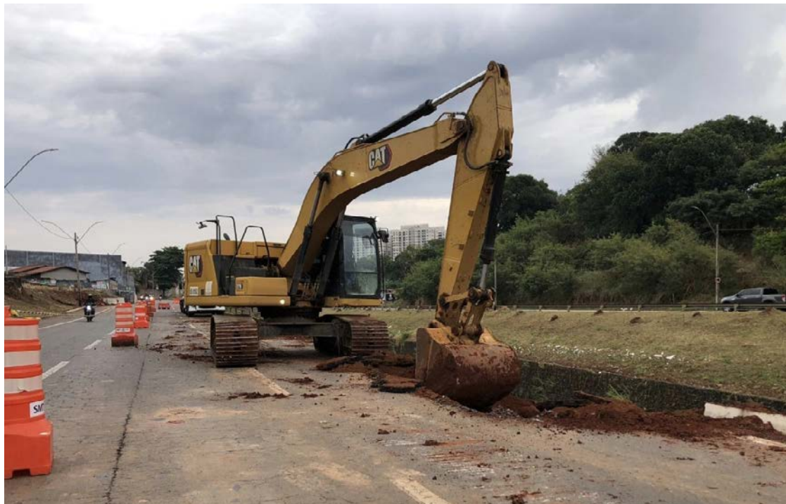
Obras na Marginal Botafogo contemplarão recuperação e ampliação do canal central, construção de bacias de contenção, reconstrução do asfalto, entre outros serviços
