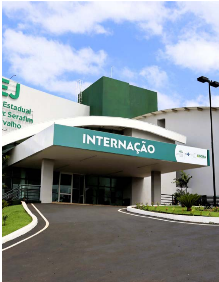
Regionalização vai ampliar o acesso e a capacidade de atendimento para cerca de 694 mil habitantes na região
