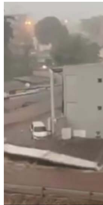
Muro que desabou após fortes chuvas na marginal Botafogo: força do vento
